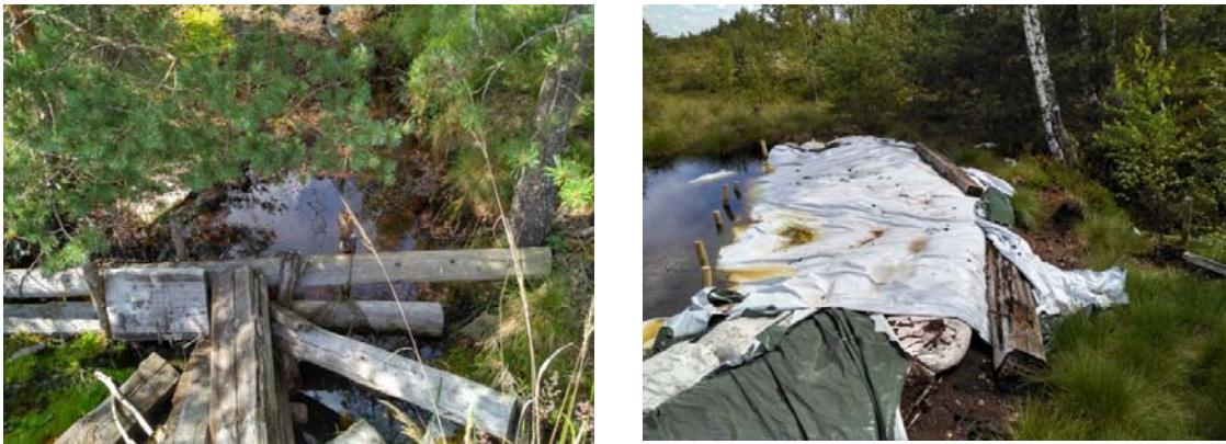
2.5. attēls. 2016. gada vasarā redzams, ka aizsprosti ir bojāti, neizturīgi, nedroši, būvēti vai stiprināti ar nepiemērotu materiālu, t.sk. polielēna maisiem. Caur dažiem aizsprostiem notiek ūdens plūsma pa apakšu. Foto: G. Freimane, 2016
