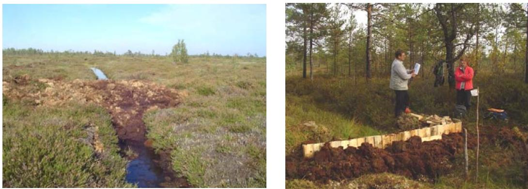
4.6. attēls. Grāvju aizsprostošanas varianti: pa kreisi - aizsprosts no vietējās kūdras grunts; pa labi - aizsprosts no koka konstrukcijas. Foto: Ostelis, 2007
