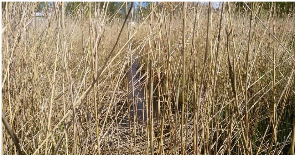
Foto 8. Langas gultnes sašaurinājums un aizaugums ar niedrēm, skats uz augšu no Valsts autoceļa P1 tilta Kalngalē (PK61/32).
