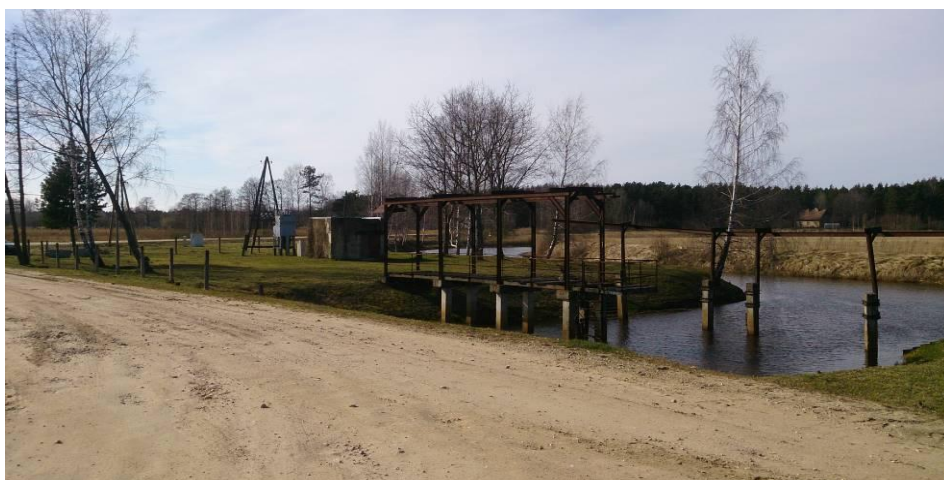
Foto 15. Mangaļu sūkņu stacija un krājbaseins (PK80/50).
