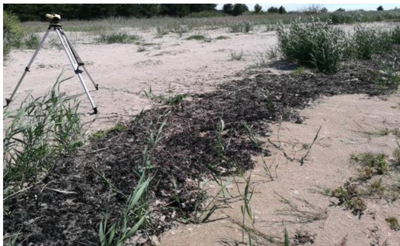
17.attēls. Krasta šķērsprofilu uzmērīšana nivelējot
