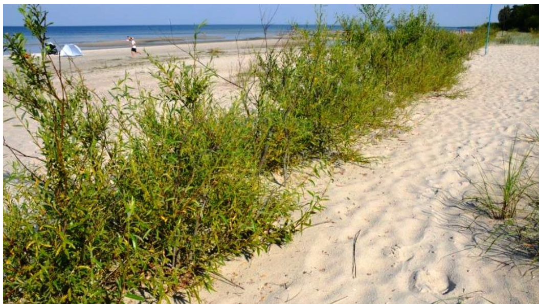
17. attēls. „Zaļās” krasta nogāzes stabilizācijas metodes. Kārķļu stādījumu rinda Bigauņciemā. Foto J. Lapinskis.
