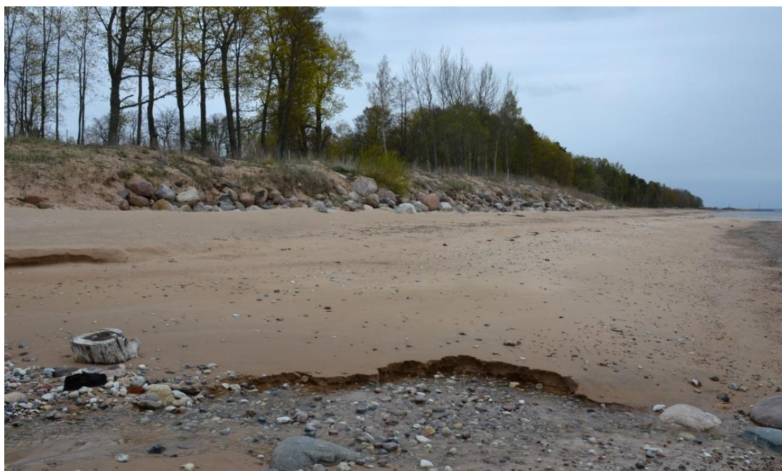
15. attēls. Rip-rap laukakmeņu stiprinājums Skultē, Rīgas līča Vidzemes piekrastē. Foto J. Lapinskis.
