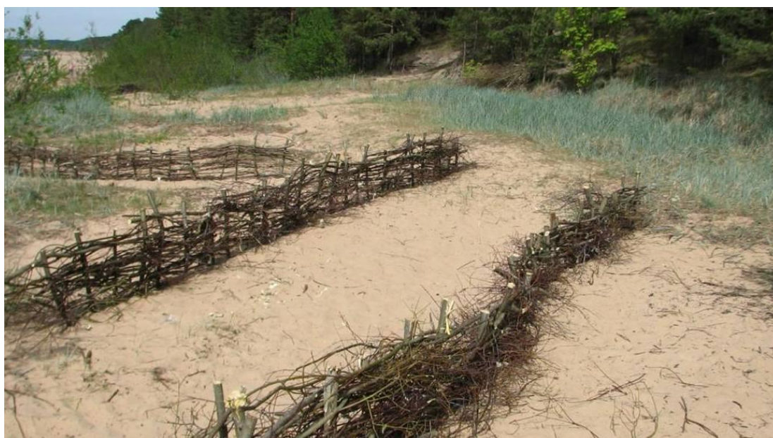
20. attēls. Zemu nedzīvu kārkļu zaru pinumu/sētiņu izmantošana eolās akumulācijas veicināšanai un deflācijas novēršanai degradētas primārās kāpas vietā (Saulkrasti, 2017).
