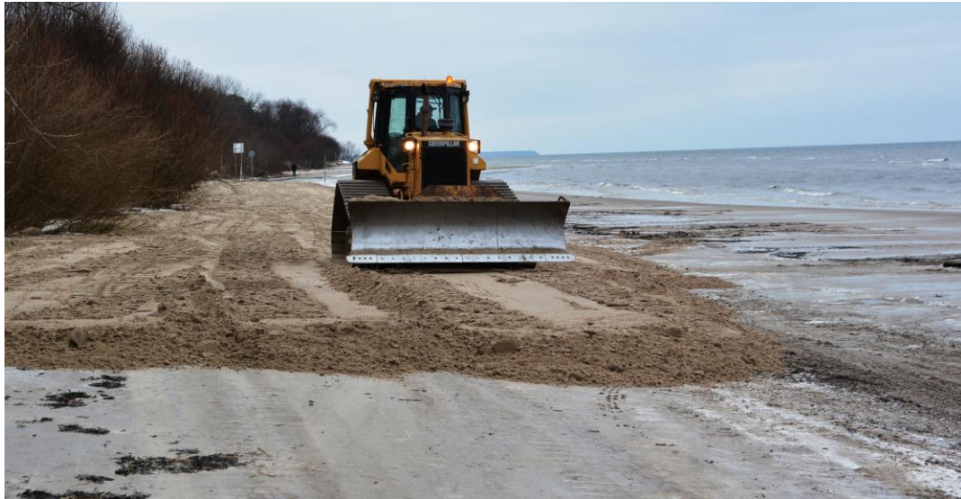
19. attēls. Krasta „piebarošana”. Smilšu uzbēršana pludmalē Kaugurciemā. Foto J. Lapinskis.
