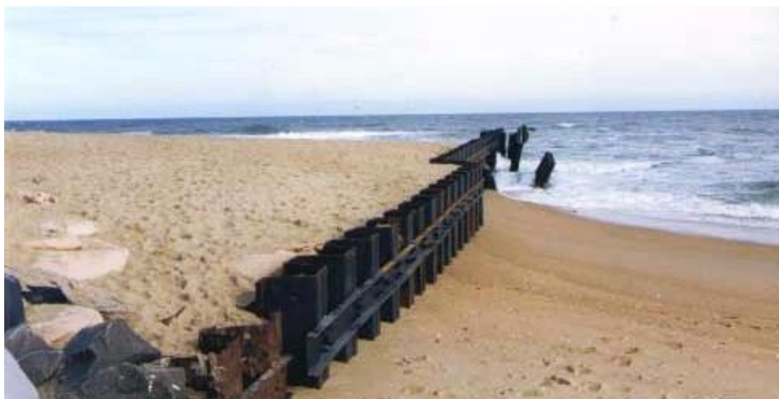
16. attēls. Krasta līnijai subperpendikulāra, aktīva hidrotehniska būve – īsa tērauda rievsienu būna Ziemeļkarolīnas štatā, ASV.
