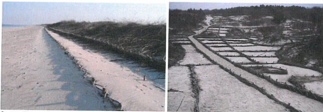
2.att. Zemu kārklu zaru pinumu/sētiņu un zaru pārklājumu izmantošana eolās akumulācijas veicināšanai un deflācijas novēršanai kāpas frontālajā daļā (attēls kreisajā pusē) un deflācijas mazināšana/atpūtnieku plūsmas organizēšana starpkāpu iepakās (attēls labajā pusē). Foto D. Pupienis
