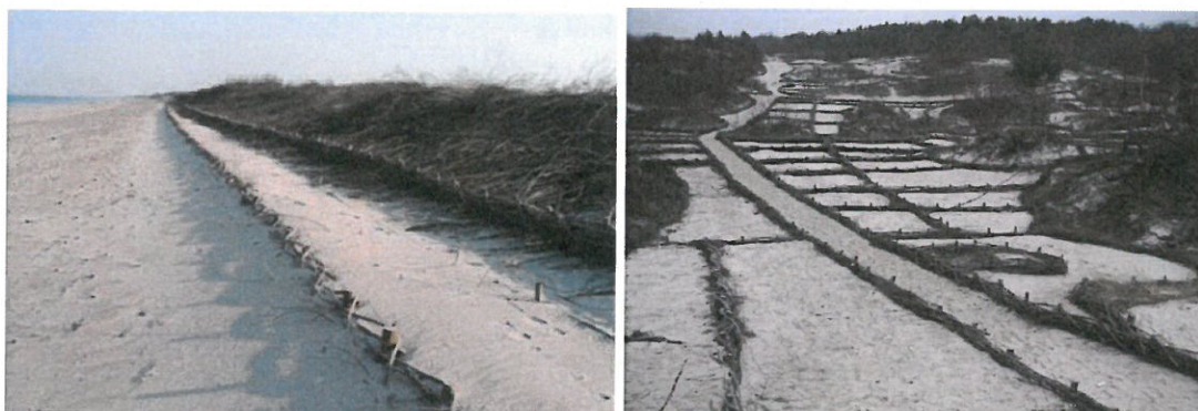
5. Att. Zemu kārkļu zaru pinumu/sētiņu un zaru pārklājumu izmantošana eolās akumulācijas veicināšanai un deflācijas novēršanai kāpas frontālajā daļā (attēls kreisajā pusē) un deflācijas mazināšana/atpūtnieku plūsmas organizēšana starpkāpu iepakās (attēls labajā pusē). Foto D. Pupienis
