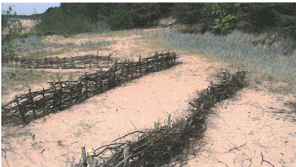
3. Att. Zemu nedzīvu kārkļu zaru pinumu/sētiņu izmantošana eolās akumulācijas veicināšanai un deflācijas novēršanai degradētas primārās kāpas vietā (Saulkrasti).
